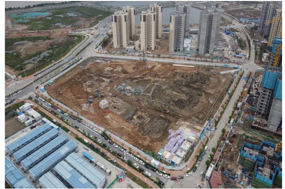
● 珠海万科星光海岸花园基坑支护工程
