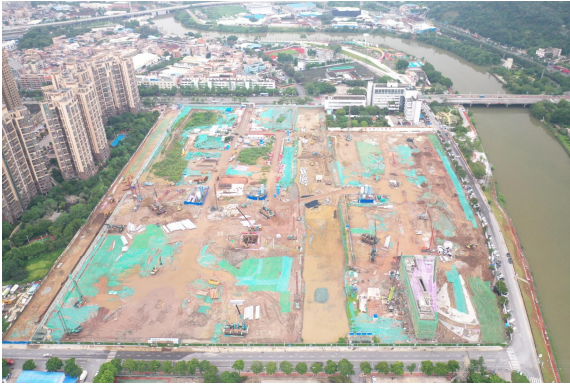
● 佛山陈村项目一批次桩基及基坑支护工程
