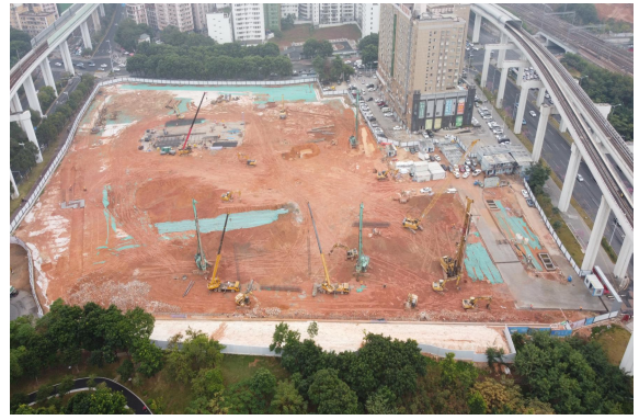
● 深圳龙华龙誉花园基础工程
